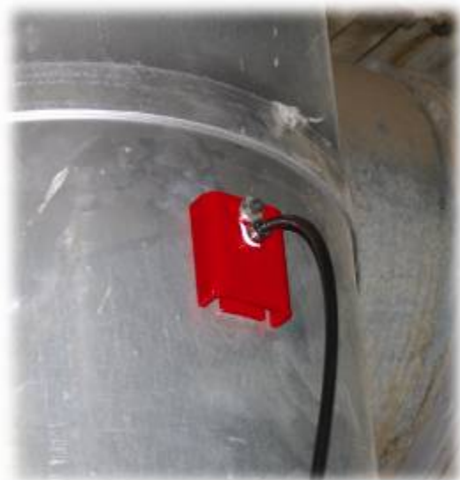
Capteur de pression statique
